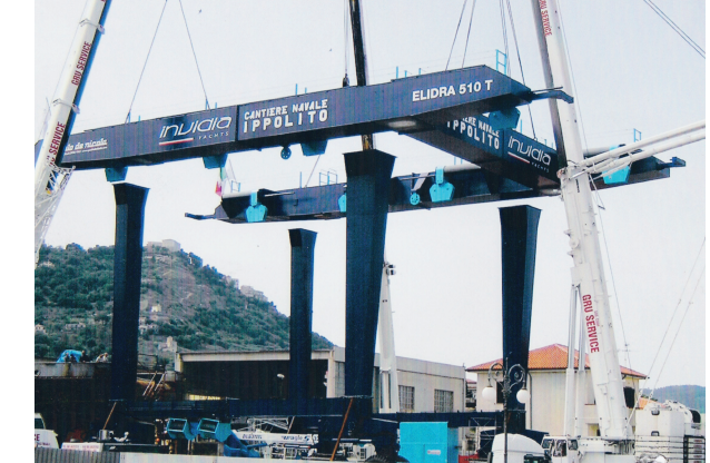
GRU PAOLO DE NICOLA presso cantiere Ippolito Santa Maria di Castellabate
